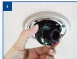
Kamera mit 3-Achsen-GyroView positionieren
